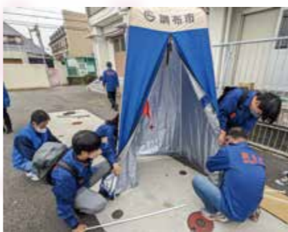
仮設簡易トイレの設置を行う調布市の皆さん
