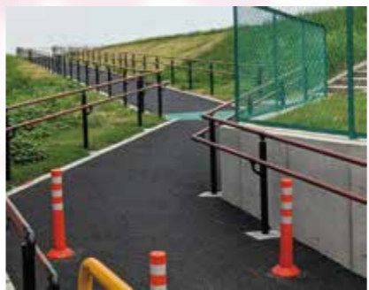
土手の下部分、緩やかで安全な傾斜
