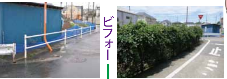
歩道に入りにくいガードレール
